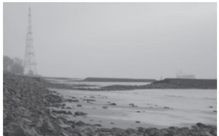
Abb. 4 Bühnenschäden seit 2001. Durchbruch des Landanschlusses bei Juelssand © Uliczka, BAW
