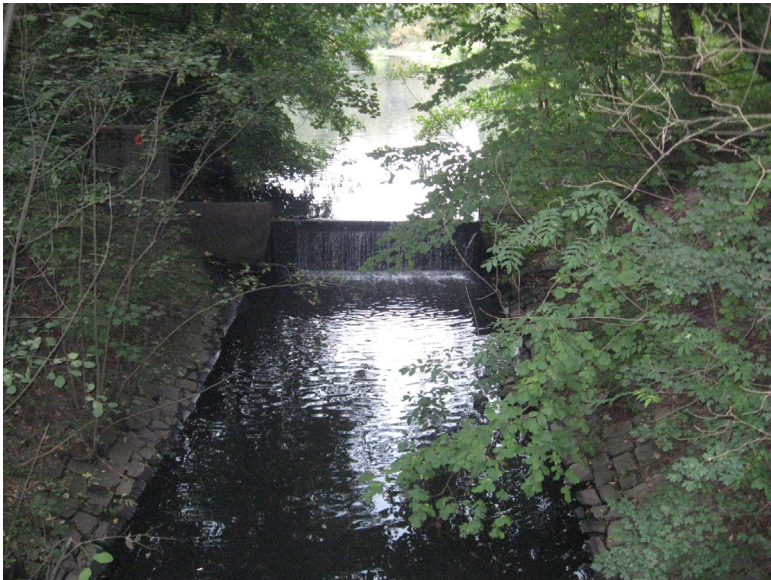
Abbildung 33: Absperrbauwerk des „HRB“ Pulverhofteich.
