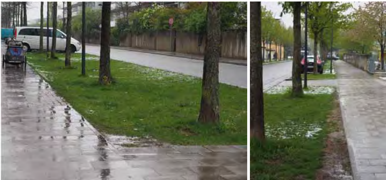
Abb. 7: Kombination aus Regenwasserversickerungsmulden und Baumstandorten in München (Fotos: Mareike Fellmer 2017)
