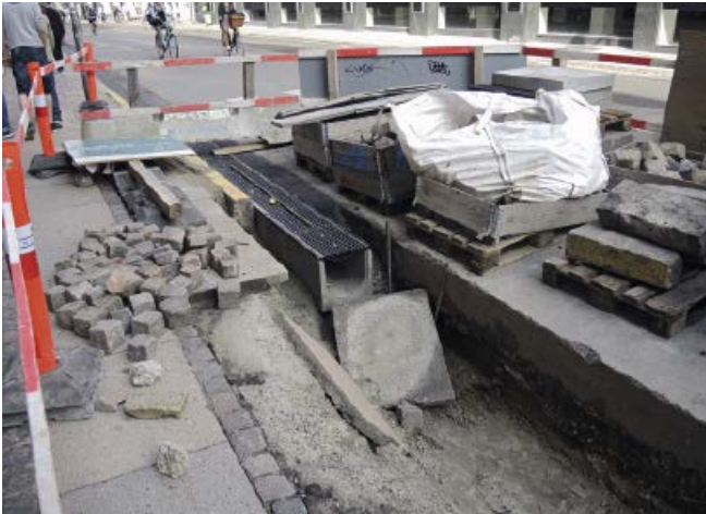
Abb. 2: Baumaßnahmen in der historisch geprägten Innenstadt. Links: Einbau straßenparalleler Entwässerungsrinnen zur Verbesserung der Wasserableitung, die jedoch kritisch diskutiert werden. Rechts: Tieferlegung des historischen Sankt Annæ Plads für den temporären Rückhalt von Regenabflüssen, bevor das Wasser ins nahegelegene Hafenbecken geleitet wird. Die Fläche in der Mitte wird noch mit überflutungstoleranten Stauden bepflanzt (Einweihung: Juni 2016).
