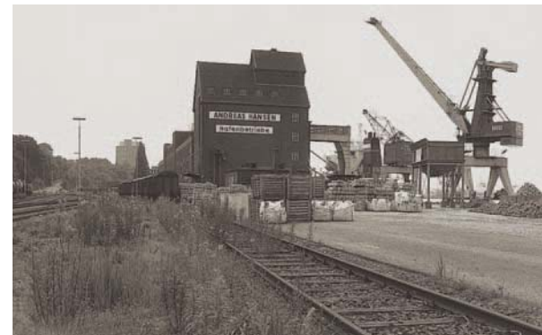
Getreidesilo vor dem Umbau
