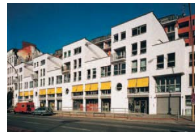
Wohnen, Gewerbe, KITA, Hafenstraße, Arch. AC
