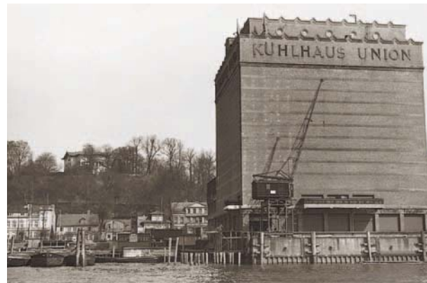
Union Kühlhaus Neumühlen vor dem Umbau
