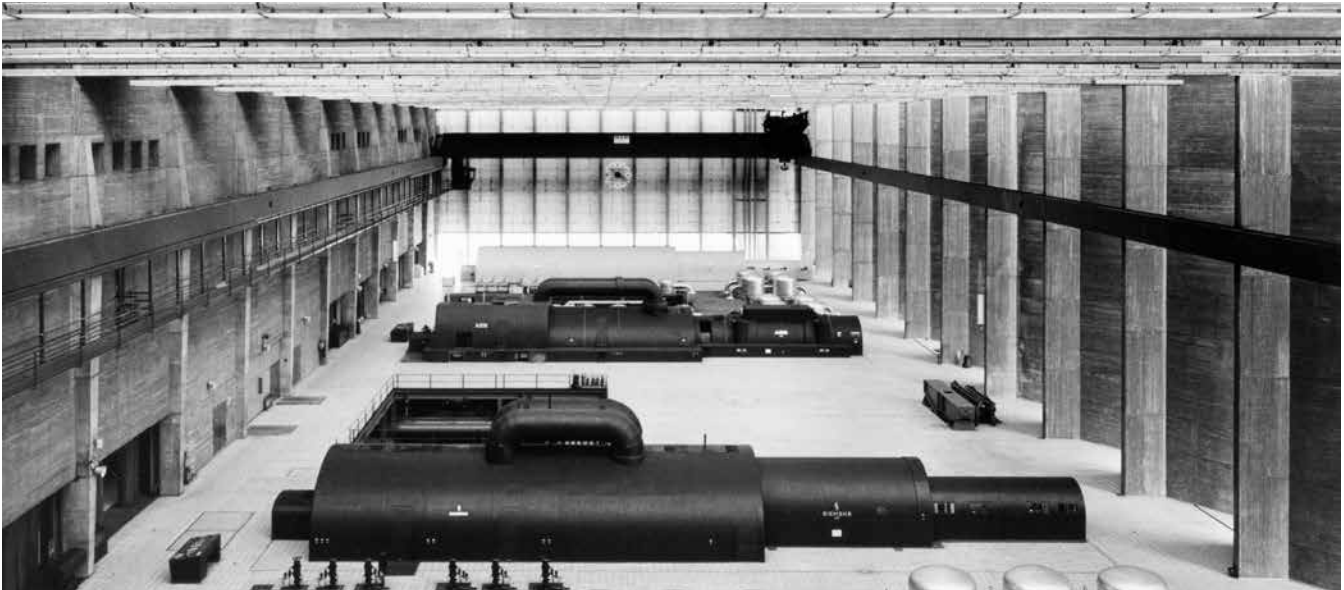
Bernhard Hermkes und Gerhart Becker, Maschinenhalle des Kraftwerk Wedels, 1965
