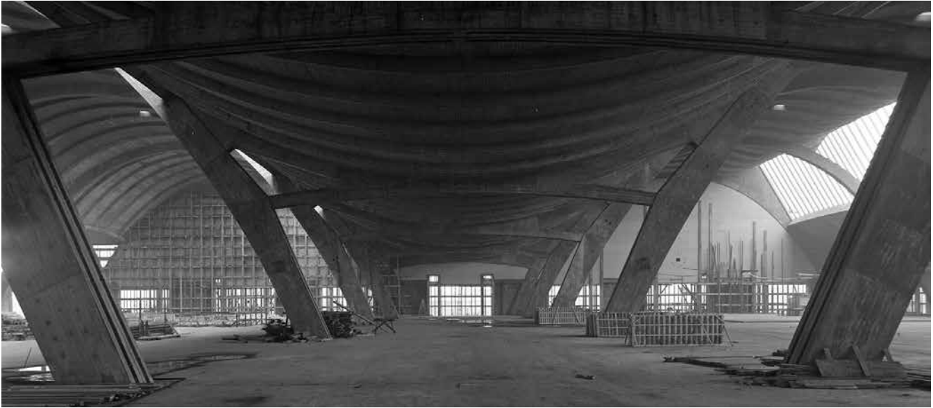
Bernhard Hermkes und Gerhart Becker, die Großmarkthalle im Bau
