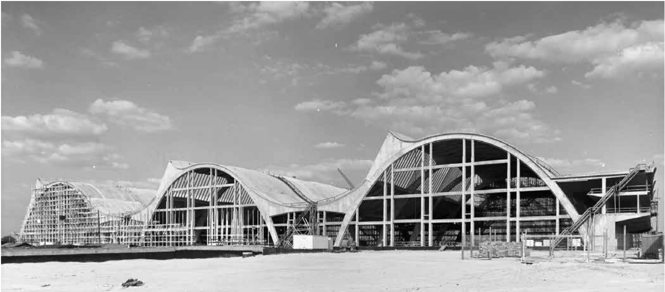
Westgabel der Großmarkthalle im Bau am 8. Juni 1960,
