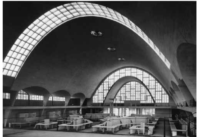
Emile Maigrot in Zusammenarbeit mit Eugène Freyssinet, Halles du Boulingrin, Reims, 1929
