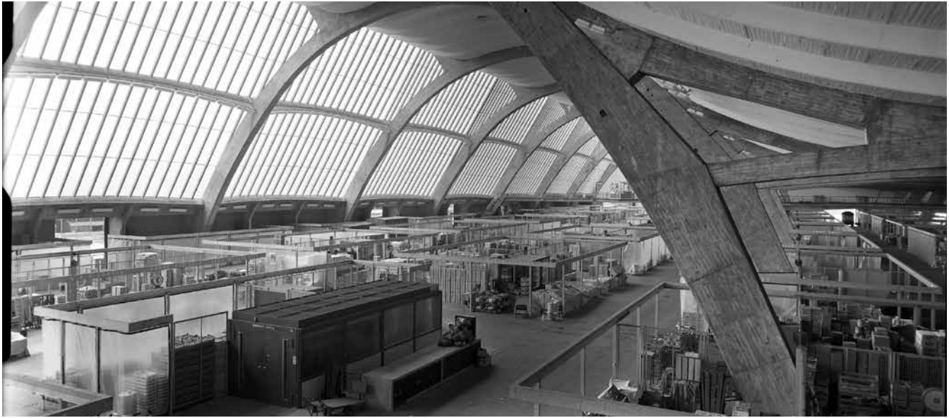
Bernhard Hermkes und Gerhart Becker, die Großmarkthalle im Betrieb, 1962
