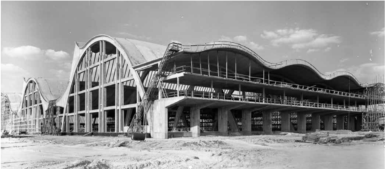
Der Südenbau im Bau
